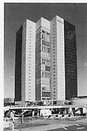
幕張本社ビル
