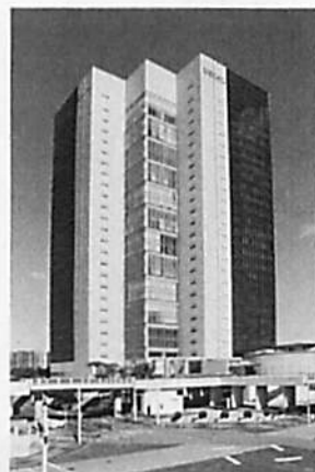
幕張本社ビル
