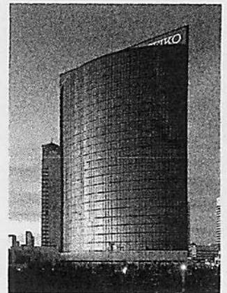
幕張本社ビル
