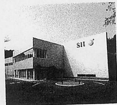
栃木本社ビル
